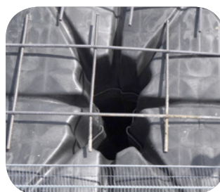
Particolare dell'ancoraggio di 4 elementi Superhercules
